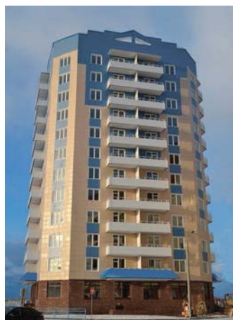
г. Псков Жилой комплекс из 2-х 12-этажных многоквартирных домов.
