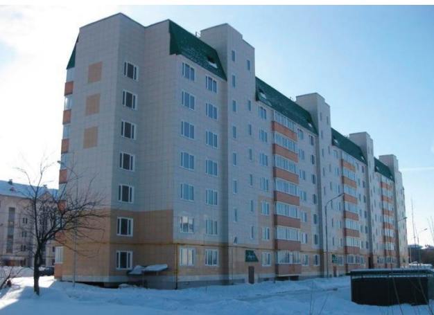
г. Руза, Московская обл. Многоквартирный жилой дом 7-этажный с техническим этажом, 5-подъездный на 136 квартир.
