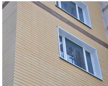
Облицовка фасадной плиткой FASADOFF
