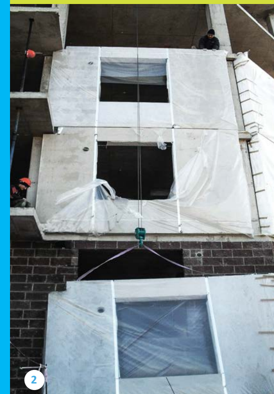
Монтаж одной ограждающей панели занимает 30 минут
