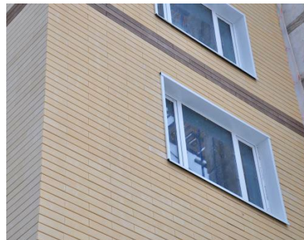
Облицовка фасадной плиткой FASADOFF
